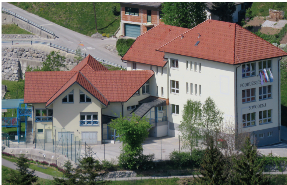
V letu 2020 je bila energetska sanirana stavba podružnične šole na Sovodnju.
