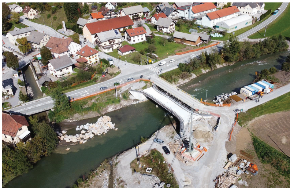
Med ukrepi za poplavno varnost Poljan je tudi izgradnja novega mostu čez Soro. (hrani: arhiv Občine Gorenja vas - Poljane)
