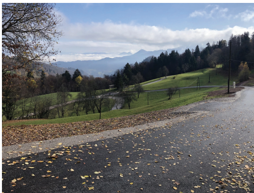
Obnovljeni odsek občinske ceste v Breznici. (vir: arhiv Občine Škofja Loka)
