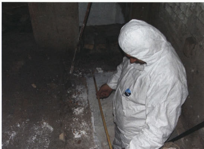
Slika 1: Priprava na remont je zahtevala, da smo se kar nekaj krat spustili v dimovodne kanale in na osnovi posnetka stanja pripravili načrte za prilagoditev dimovodnih kanalov in priključkov na čistilno napravo.
