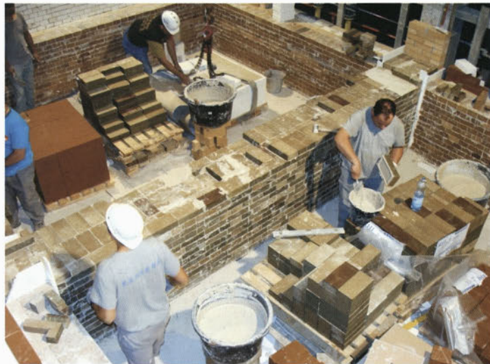
Slika 8: Detajl z gradbišča- srednji zid se ponovno gradi.
