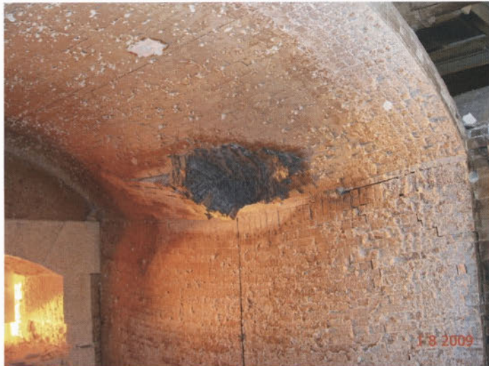
Slika 5: Desno poseden srednji zid, na sredini keramično povarjena luknja na svodu leve komore, povsem levo spodaj z zapirali zaprta ustje leve komore.
