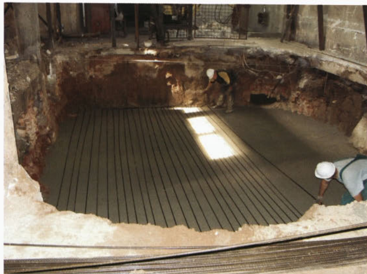
Slika 5: Gradbena jama za temelje regenerativnih peči, na sliki je že položen podložni beton, in pričetek izdelave armature
