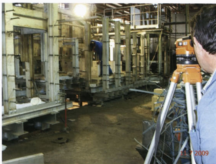
Slika 6: Zelo pomembna faza gradnje je niveliranje-usklajevanje nivojev delovišč obeh peči
