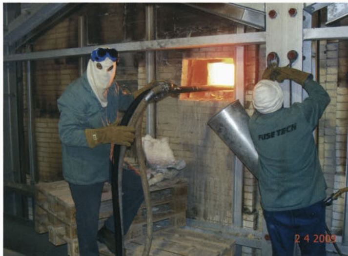
Slika 3: Na zadnji steni regeneratorjev naproti gorilcem smo izžagali luknjo in skozi njo z vodno haljenimi cevmi varili luknje z maso na osnovi kovinskega silicija, ki smo jo po ceveh s kisikom vpihovali na mesto varjenja, kjer je silicij zgorel in tvoril stabilni keramični sloj.
