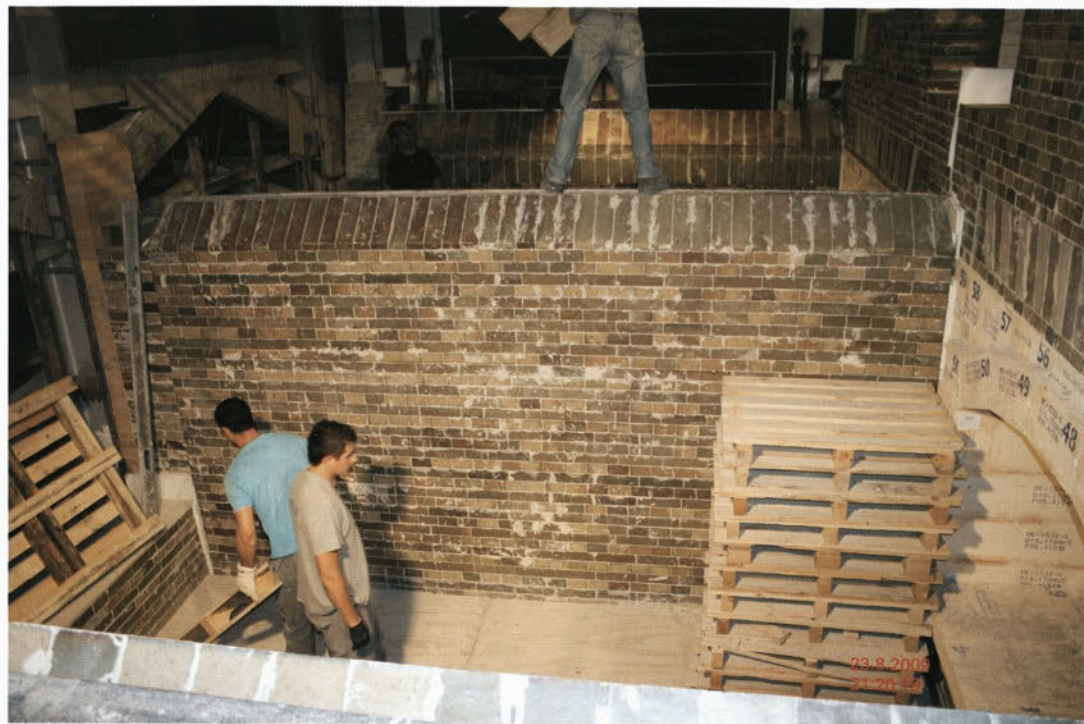
Slika 9: Nov srednji zid, pogled z desne komore.
