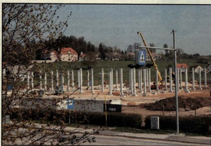
Pričetek gradnje Tušovega supermarketa po meri najzahtevnejših kupcev na Polzeli
