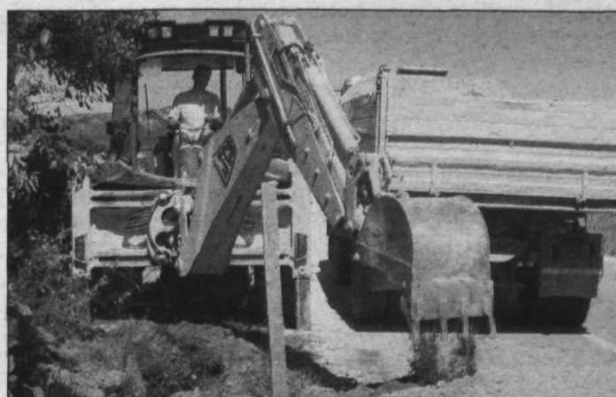
Izgradnja kanalizacijskega sistema na Krškem polju se je začela pri Bregah; takole so stroji prvič zakopali v zemljo.
