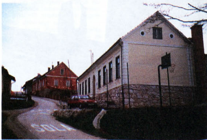
Stara šola na Ponikvi, ki je letos dobila novo fasado in okna, čaka pa jo še zamenjava ostrešja, bo v prihodnjem letu praznovala 120 let.
