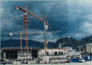
Mercator gradi poslovno stanovanjski objekt.
