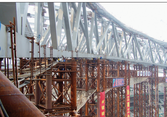
Enerpacove hidravlične enote na vsakem od 30 stebrov notranjega kroga
