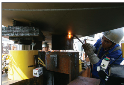
Ločevanje strešne konstrukcije in začasnih podpornih stebrov
