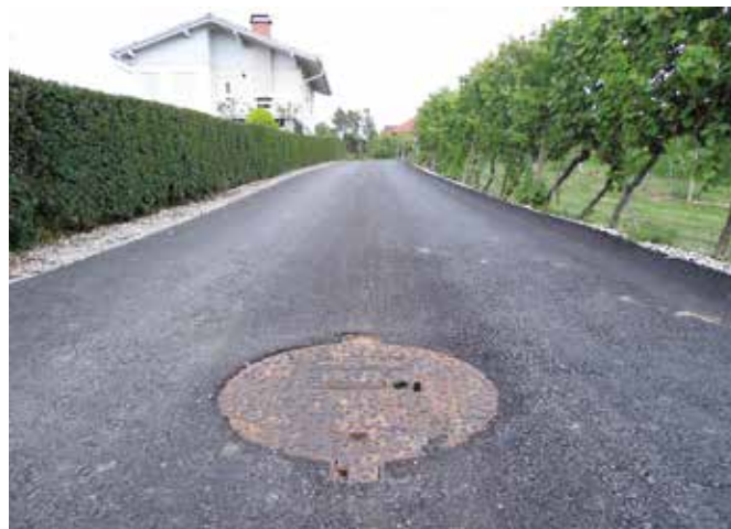
Kanalizacija Bogojina – Vršič
