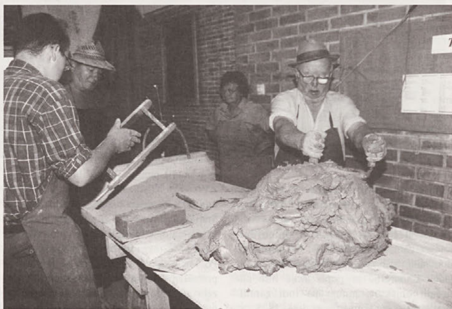
Ročna izdelava cegla-opeke, slikovno gradivo: Jože Miklavc
