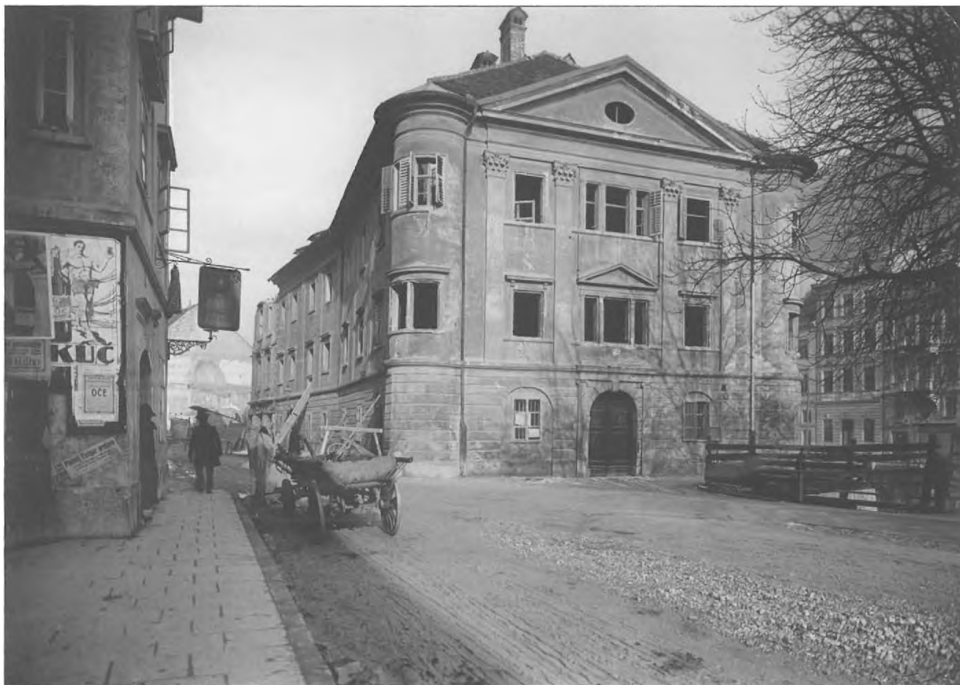
39 Nekdanja Obrezova hiša na Novem trgu 8 (podrta o. 1913), o. 1910, fotografija / 17 x 12,1; ZAL, Fototeka (LJU 342), POZ II/A2-074
