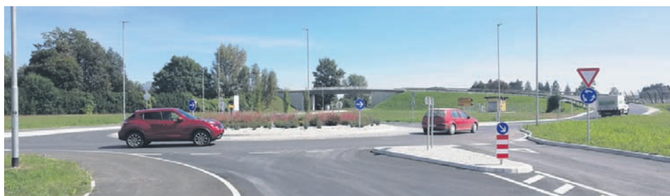
Novo krožišče v poslovni coni Žalec – Južno od železnice
