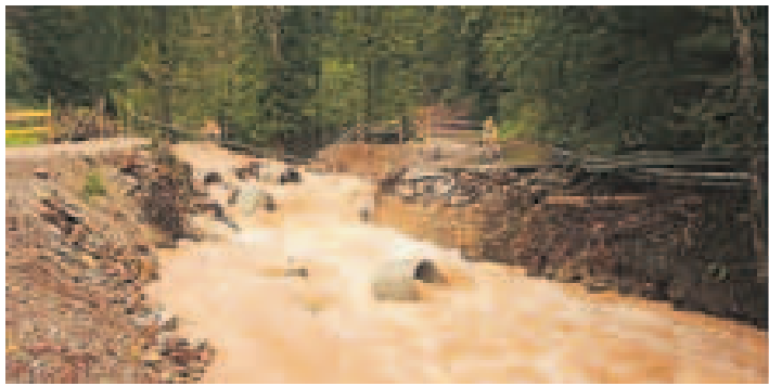
Vode ne smemo podcenjevati; na sliki levo je podrto zasilno mostišče v Petačevem grabnu dne 13. 9. 2014, kjer se vidi nekaj od 14 betonskih cevi, ki so tvorile dva tunela. Na desni sliki z dne 22. 10. 2014 pa je ponovno razdejanje na mestu popravljenega mostu.
