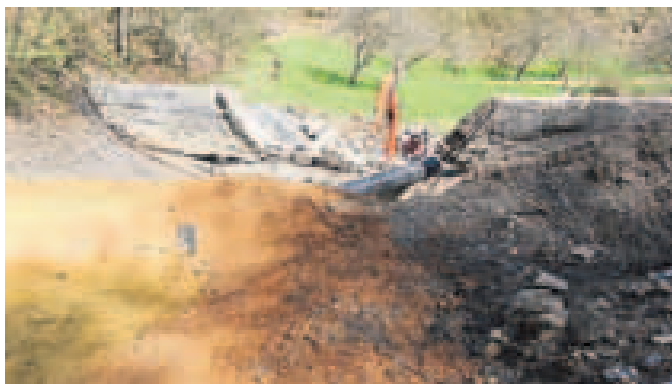
Zadrževalnik v Dolenji vasi so maja lani sanirali in očistili, lepo je vidna cev za pretok vode v njenem mirnem času.
