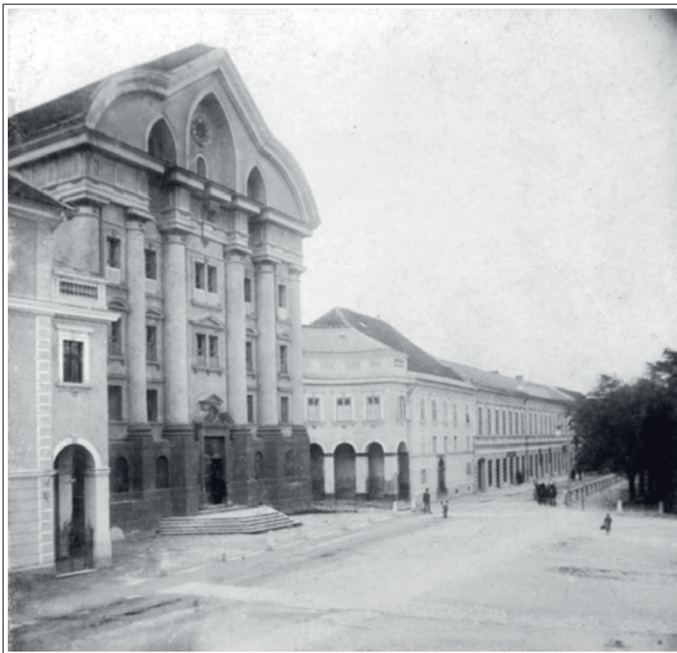
Sl. 2: Vzhodna fasada uršulinskega samostana s cerkvijo in pritlično uršulinsko šolo na severu iz leta 1889 (hrani Arhiv ZVKDS, OE Ljubljana).
