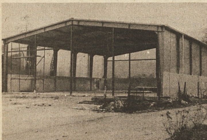
NOVO 1984 — izgradnja modernejših servisnih delavnic Evrotransa.
