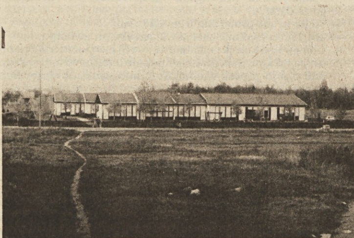
Novo 1984 — Že spomladi je bil dograjen prizidek vrtca v Ribnici, prvi rezultat najnovejšega samopriskpeva v občini. Kljub temu je vrtec še premajhen, saj čaka na sprejem spet skoraj 60 otrok.
