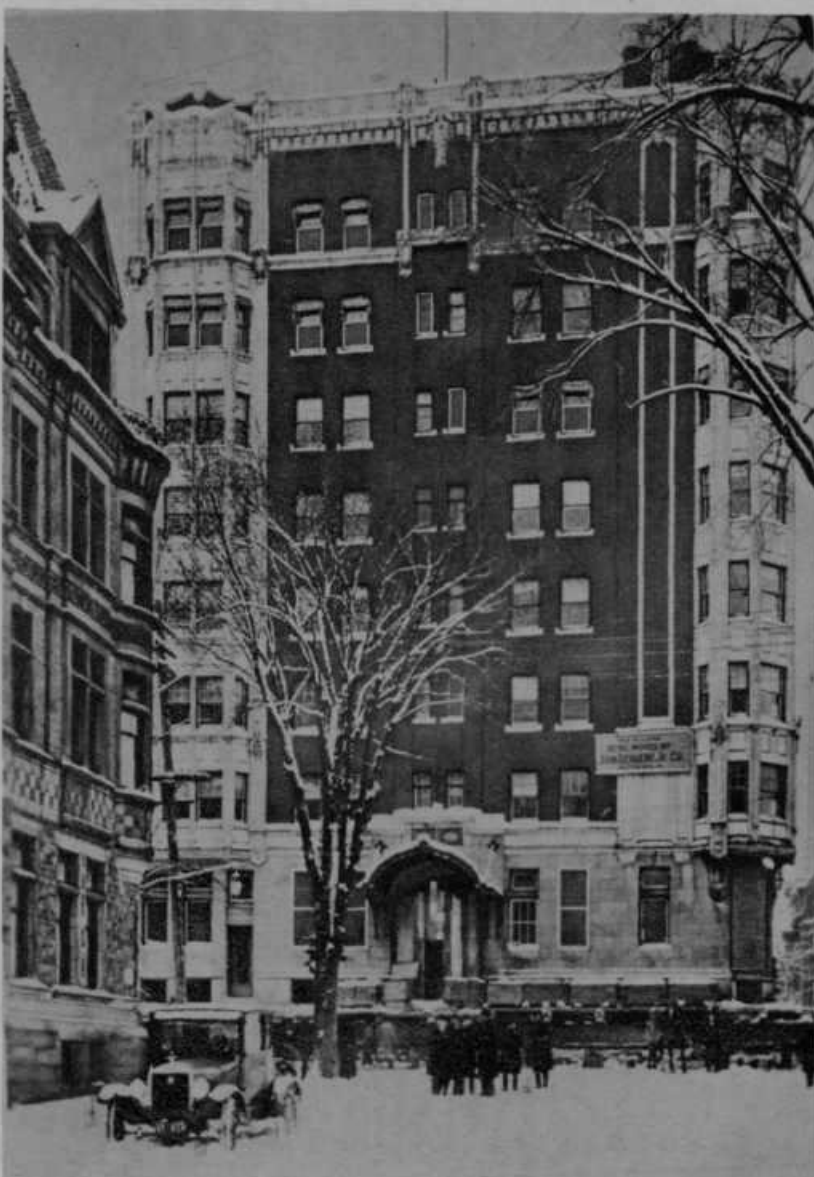
V mestu Albany v Združenih državah v Ameriki je bila regulacijskemu načrtu na poti sedemnadstropna hiša. Praktični Američani niso dolgo pomišljali: pod hišo so podvalili ogromne valjarje ter jo počasi potisnili na ogel ulice, kjer so jo hoteli imeti.
