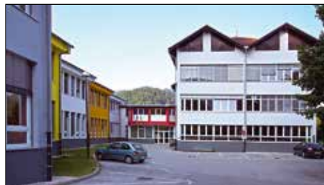
Šolska stavba v Otokih danes. Foto: Igor Mohorič Bonča
