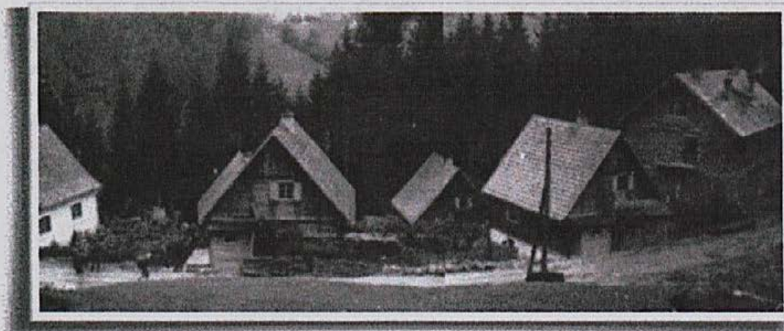
Pogled na Podgrad- Kolonijo, uradno Cezlak
