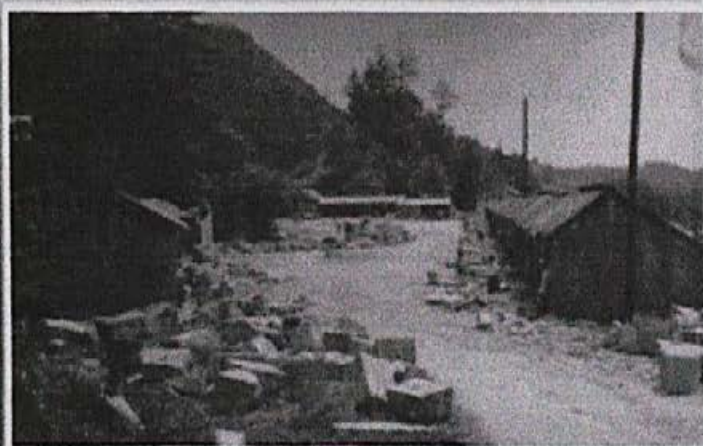
Barake na delovišču
