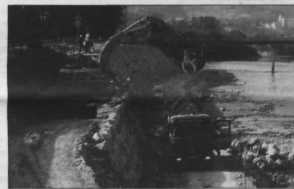
Gradnja brežin ob reki Savi se zaključuje.
