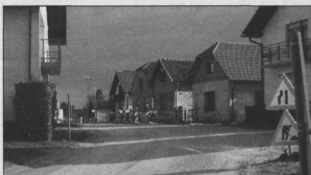
Gradbišče na Bregah
