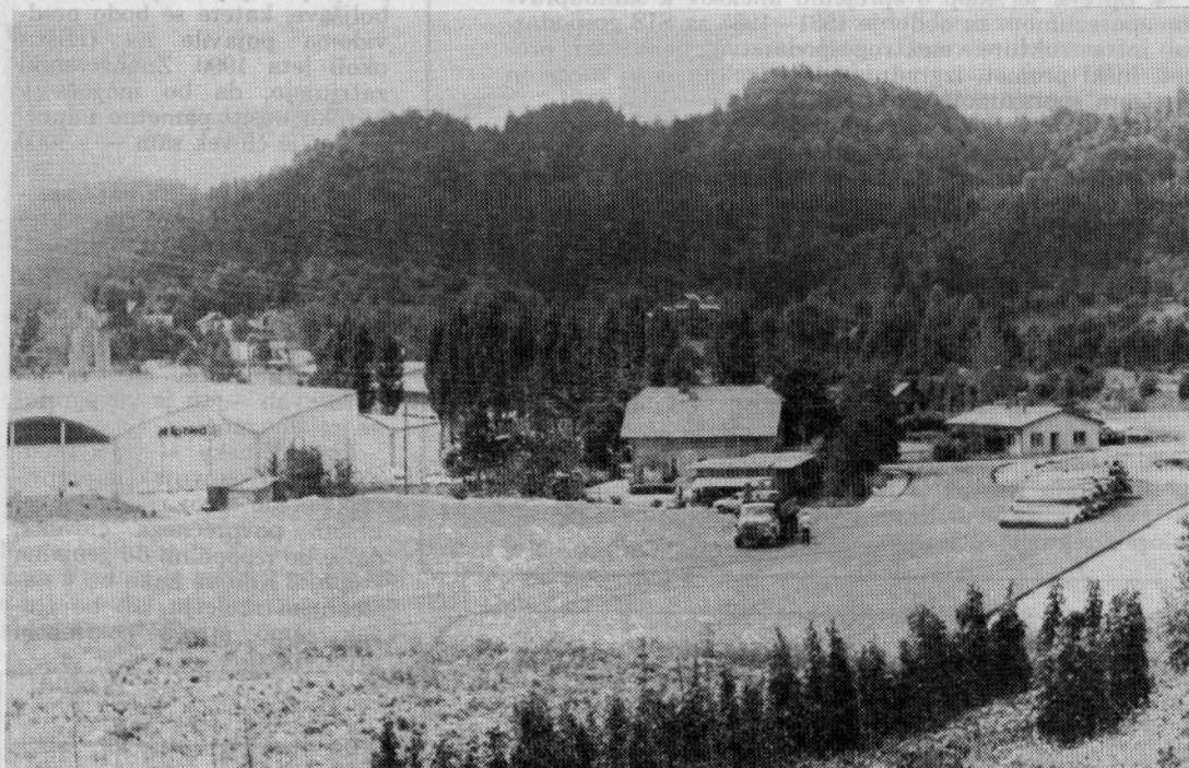
Del platoja za neolupljeno hlodovino je asfaltiran
