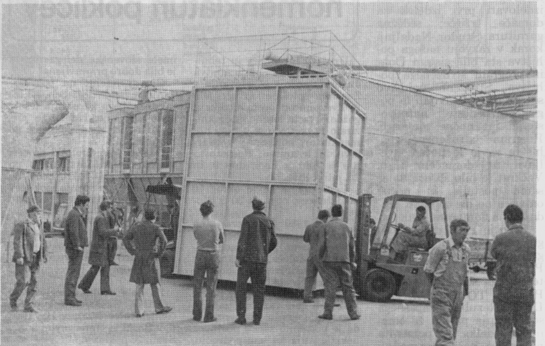
Delo pri montaži povečave silosa ob kotlovnici
