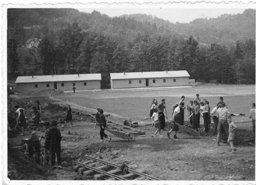
Gradnja stadiona NA Lipi je trajala od leta 1955.
