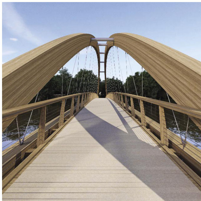
Slika 6 • Navznoter nagnjena loka povečujeta stabilnost konstrukcije
