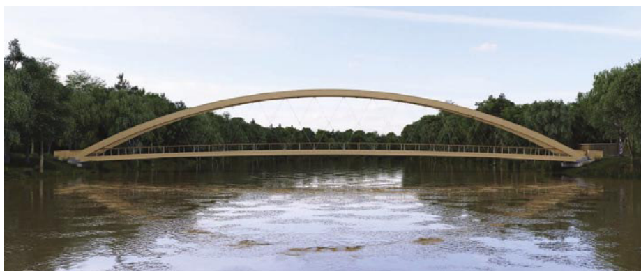
Slika 1 • Pogled na brv
