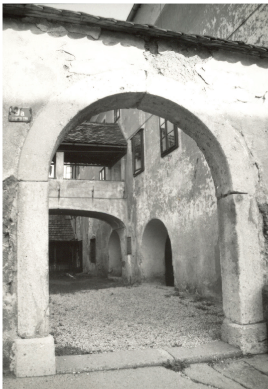
Portal mestne ubožnice, zgrajen v začetku 18. stoletja, pred obnovo. (foto: Janez Misson, fototeka Loškega muzeja Škofja Loka)
