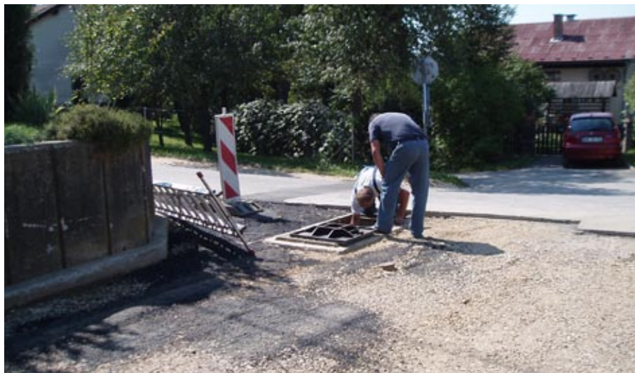
Izgradnja črpališča Vitomarci pri Černelovi kapelici
