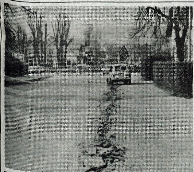
Po odprtju prenovljenega kokrškega mostu naj bi obnovili in razširili še Oldhamsko in Žagarjevo cesto. Zahteve lastnikov zemljišč, ki bi se jim cesti s pločnikom in kolesarsko stezo zajedli v hiše in vrtove, so po grobi oceni vredne okrog milijona nemških mark.
