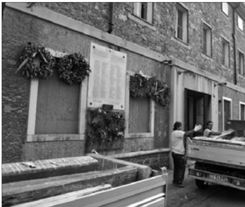
Začeli so čistiti in zavarovati stavbo nekdanjega Narodnega doma
