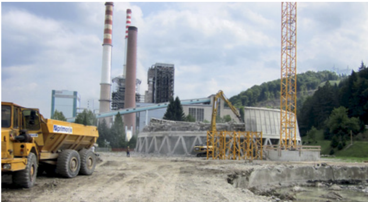
Priprave prostora za nov blok že potekajo.
