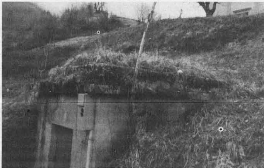
Uno dei due depositi d'acqua a Topolò, nel comune di Grimacco
