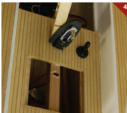
Lepljenje cevk in nosilca volana
