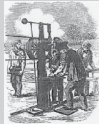
□ Slika 8. Delavci na gradbišču pripravljajo posamezne lesene sestavne dele: vrtni stroj (The Illustrated London News, 1850)
