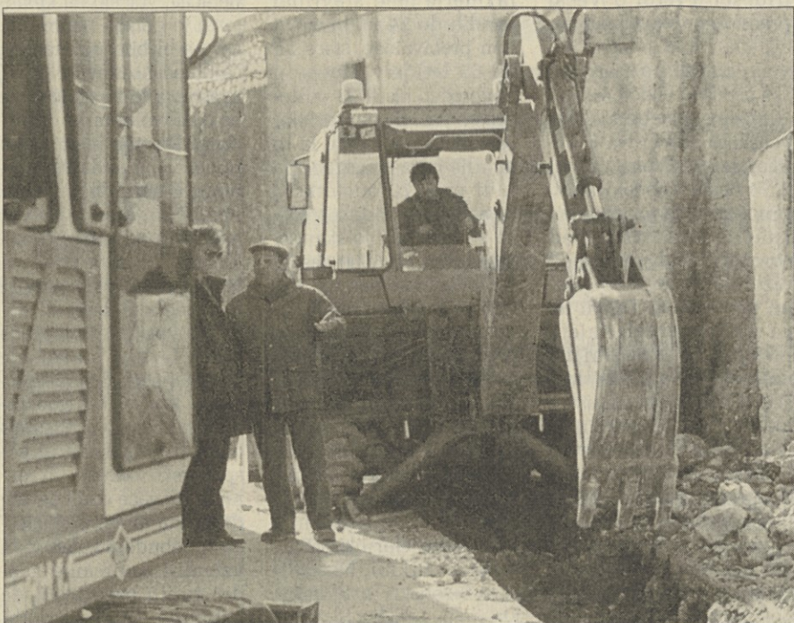
Gradnja glavnega voda hubeljskega vodovoda skozi Batuje. V kratkem bo zgrajen še vodovod do Črnič. Obilujljajo, da bo to še letos. (Foto: A. Lipovž)
