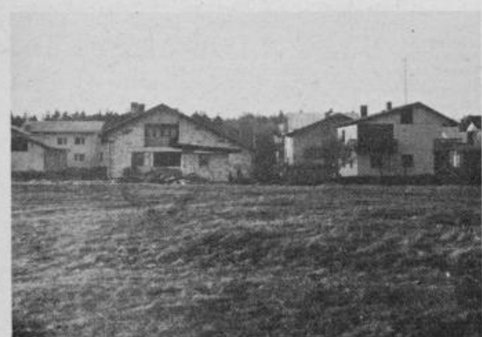
V Njivercih je vse več novih hiš in gradbišč.
