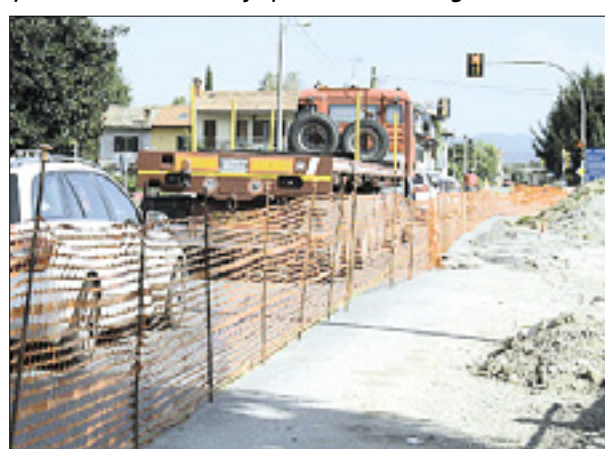
Gradbišče na območju križišča
