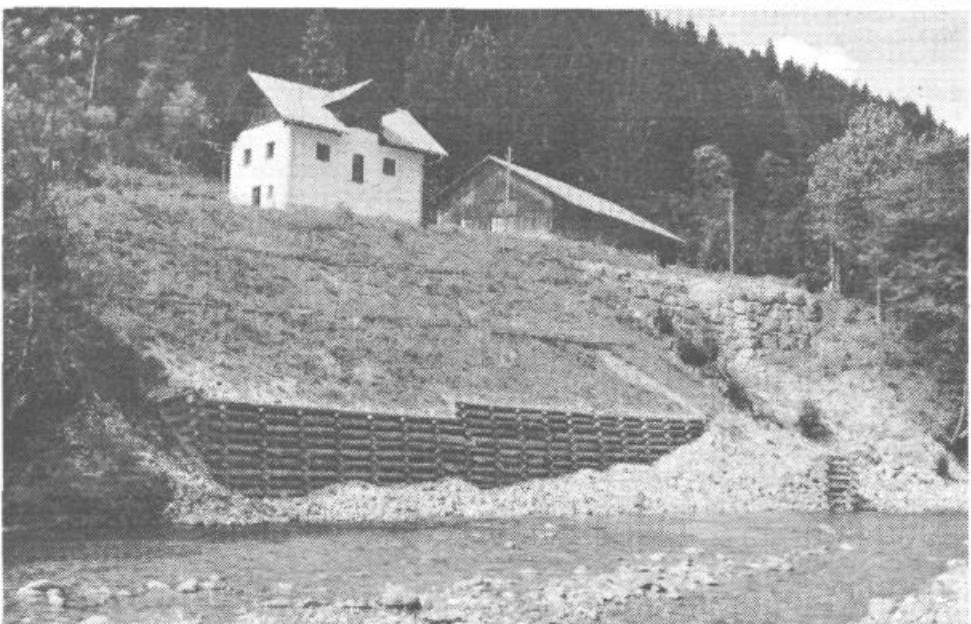
Tudi v hudourništvu uporabljajo v zadnjem času pristope in materiale, ki so bolj prijazni okolju. Tako so n.p. pri Prušnikovi domačiji nad Savinjo uporabili za varovanje brega pred deročo vodo leseno kašo, za zaščito brežine pred površinskim delovanjem vode zatratitev in vrbov poplet, strugo hudourniškega Pršnikovega grabna pa so utrčili s kamnito pregrado iz avtohtonega kamenja. (Foto: S. J.)
