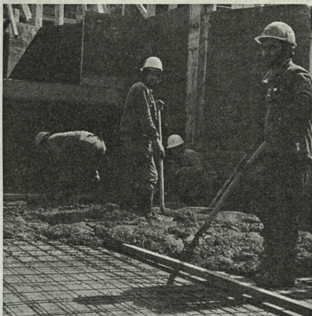
Sl. 7. Prekrivanje jeklenih plošč z zaščitnim betonom
