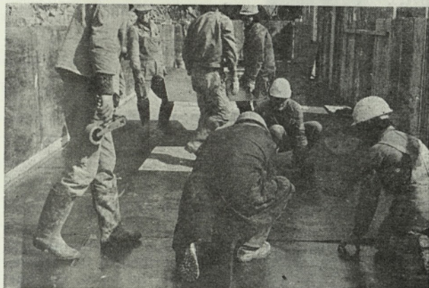
Sl. 6. Prekrivanje podložnega betona z jeklenimi ploščami
