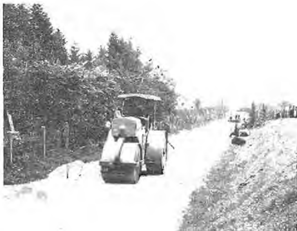
Profiliranje in valjanje cestišča
