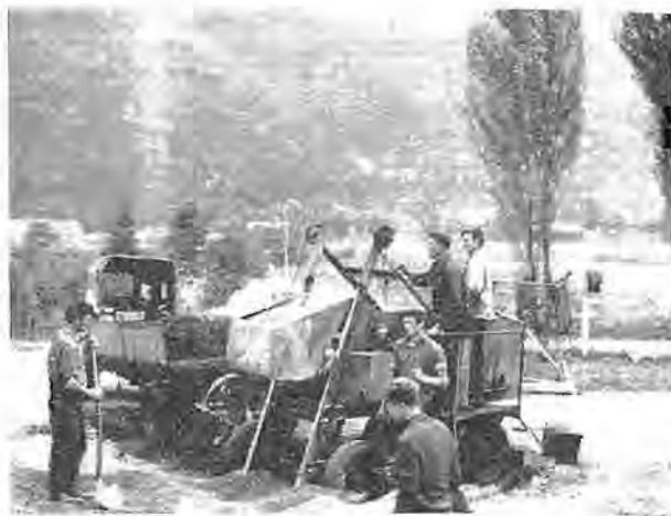
Stroj za mešanje bitumenske emulzije z agregatom
