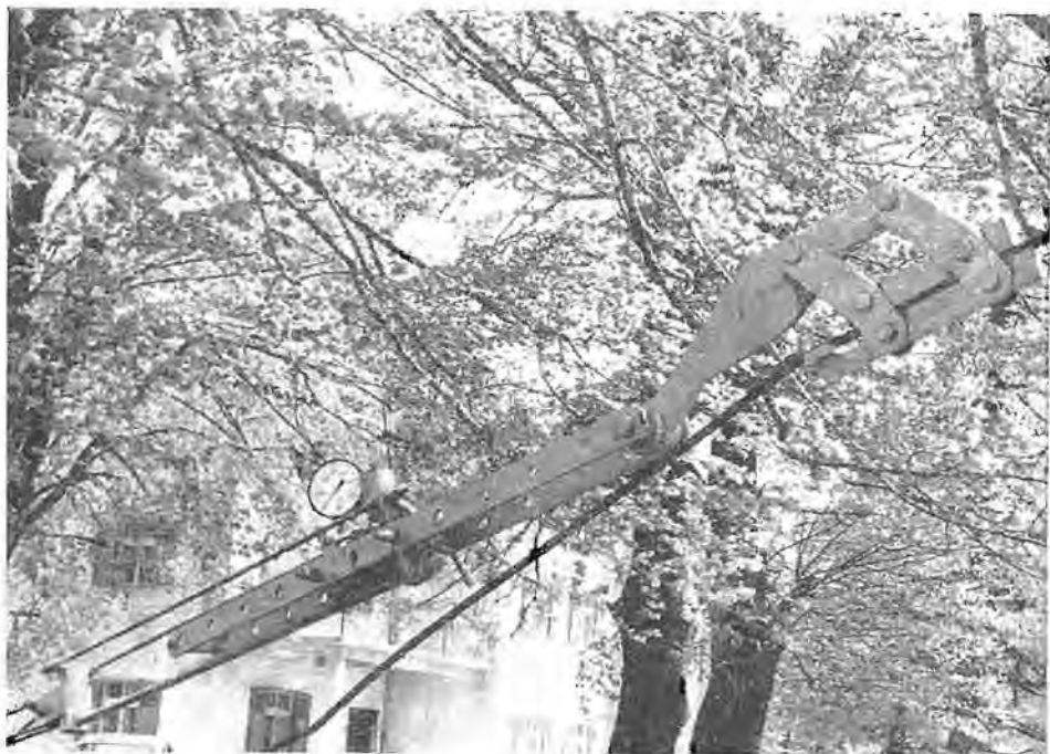
Slika 5. Hidravlična napenjalna naprava
