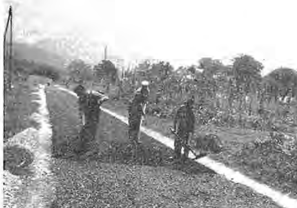
Planiranje asfaltne zmesi
