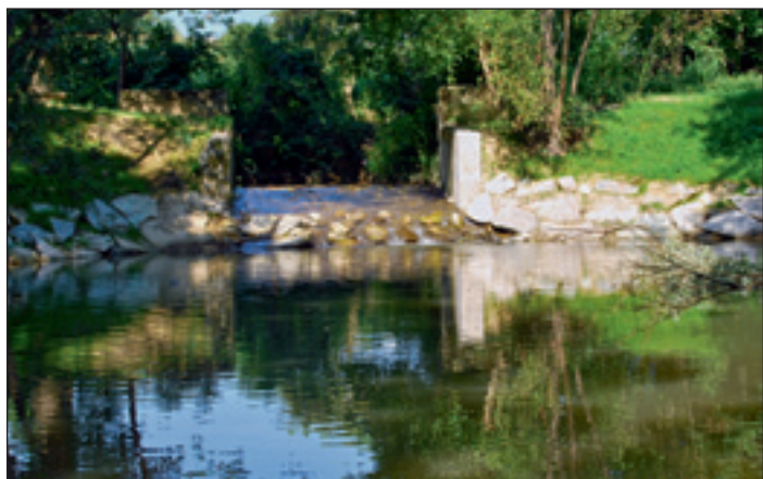
Splavnica po sanaciji
