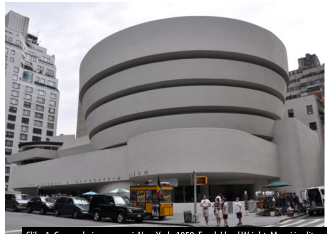
Slika 1: Guggenheimov muzej, New York, 1959, Frank Lloyd Wright. Muzej je vlit v betonski stolp v obliki logaritmčne spirale, ki se dviguje proti dvanajstkupolni strehi. (Foto: Zbašnik-Senegačnik)
