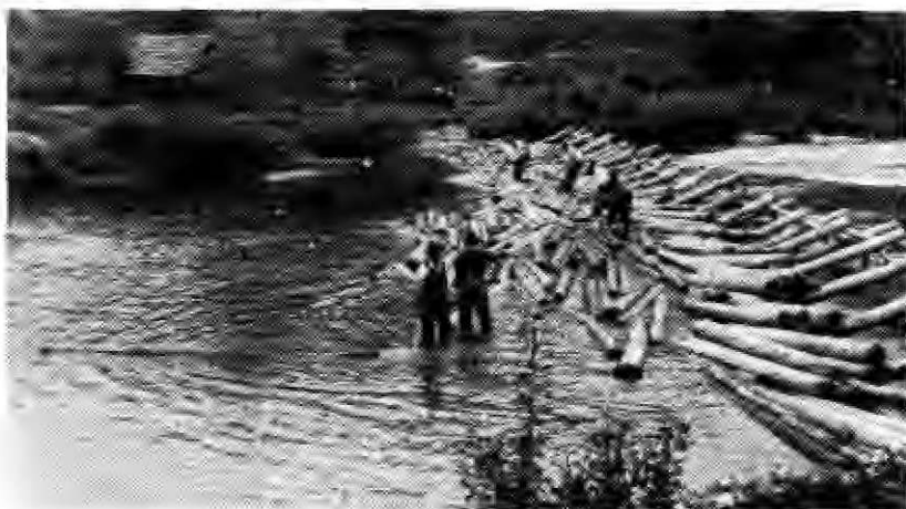
Ko so plavili les, so Savinjo pregradili, da se je hlodovina zbirala in razdelila na lastnike, „Zalaga“ na Savinji.
