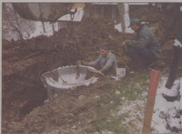
Kruh si služim kot gradbeno-komunalni delavec v Avstriji in tale posnetek je nastal pred nedavnim, ko smo gradili kanalizacijsko omrežje na Gradiščanskem. Jaz stojim v jašku in »pomagam« stroju pri nameščanju cevi.
