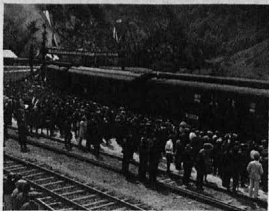
Otvoritev novega mostu v Zidanem mostu.
