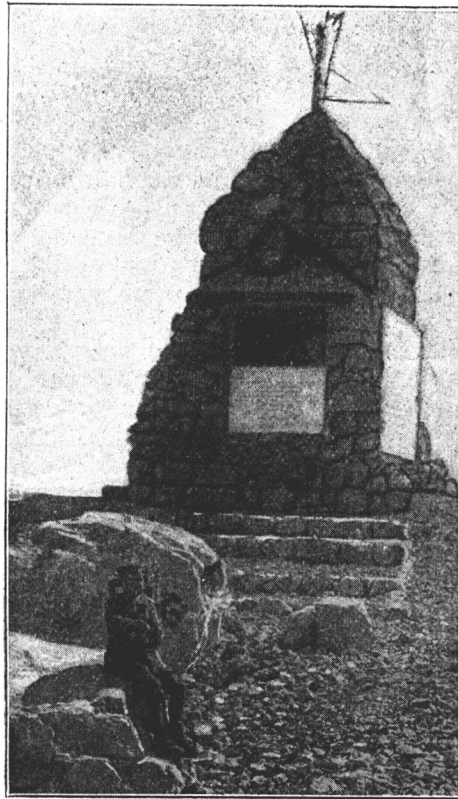
Spomenik na Krnu, ki ga je strela poškodovala.
