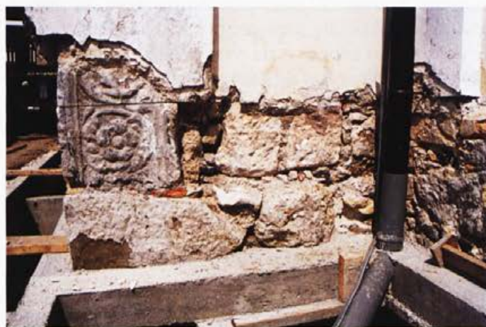
Kamnita roža, odkrita pri obnovi cerkve na Križu. Foto: Jože Pavlič.
