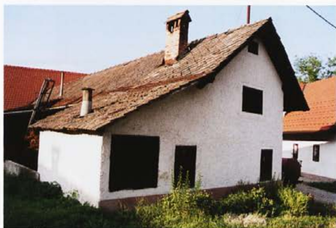
Kozlova sušilnica sadja je v levem kotu te stavbe – gospodarskega poslopja nasproti Kozlove hiše. Foto: Jože Pavlič.
