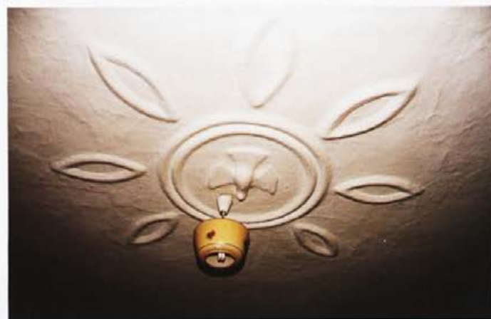
Strop v Bútalčevi hiši na Klanecu z reliefom Sv. Duha. Foto: Jože Pavlič.
