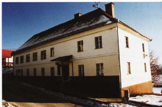
Prednji del Glavarjeve bolnice. Foto: Jože Pavlič.
