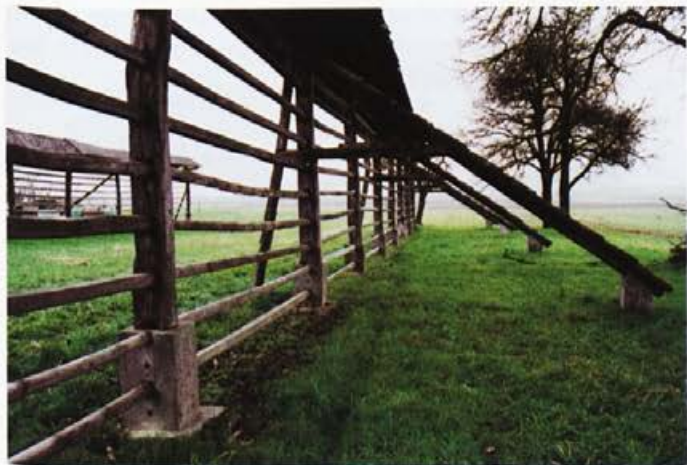
Podporniki na Žnidarjevem kozolcu. Foto: Jože Pavlič.
