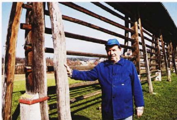
Lesen Križlnov kozolec je gospodar z betonskimi podstavki zavaroval pred vlago v tleh. Foto: Jože Pavlič.
