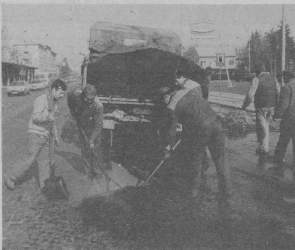
Na bežigradski magistrali delavci Cestnega podjetja krpajo luknje, ki jih je napravila zmrzal. Spomlad pa bo Titova cesta postala večje gradbišče: od štadiona do križišča s severno obvoznico bodo položili novo asfaltno prevleko.
