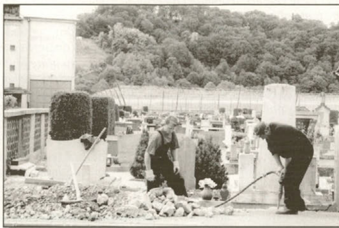
Javna delavca pri obnovi pokopališke ograje
