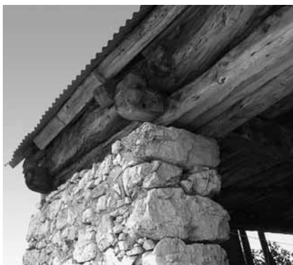
Sestav kapne, stropne in strešne konstrukcije pri hramih planine Za Črnim vrhom FOTO: MIROSLAV KAJZELJ
