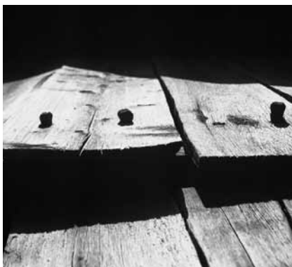
Čelni opaž – paze, pritrdjene s cveki, na hlevu v Trenti FOTO: MIROSLAV KAJZELJ
