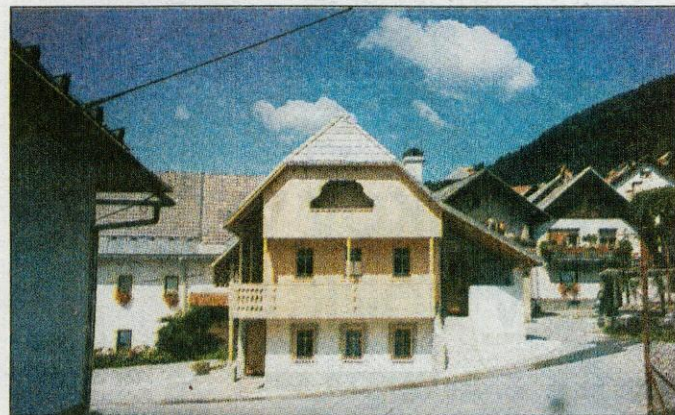
Staro kovačnico na Dovjem so podrli in zgradili zelo lepo stavbo sredi vasi...
