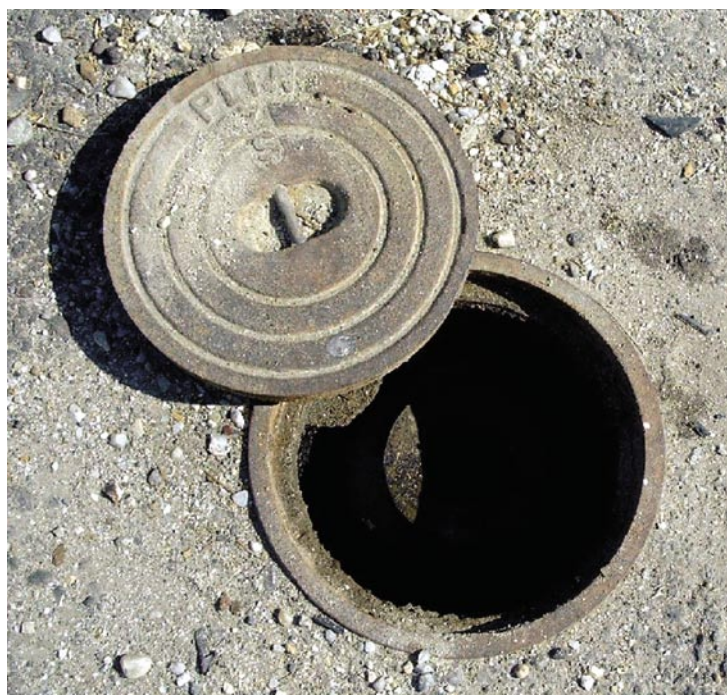
Slika 10 • Pokrov inšpekcijskih jaškov
