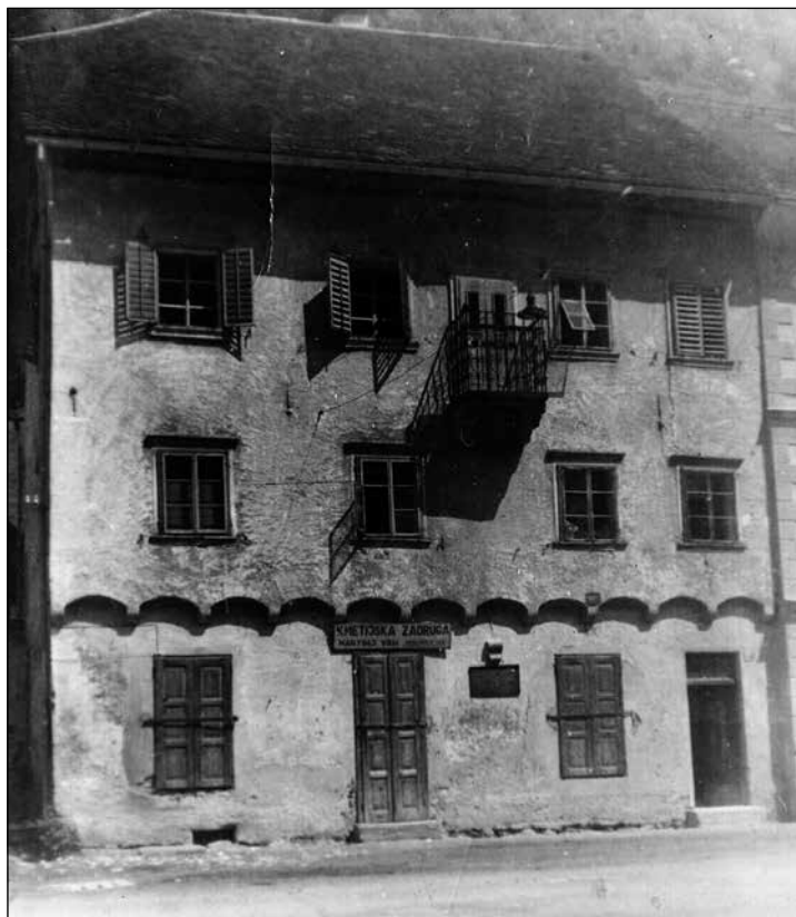
Sprednja stran Plavčeve hiše še v lasti Kmetijske zadruge Martinj Vrh. Zanimiv prehod z malimi oboki na prehodu iz pritličja v prvo nadstropje. V drugem nadstropju je balkon iz zelenega perachiškega tufa s kovano železno ograjo. Levo je še viden del zidanega obočka, ki je zapiral dvorišče.
