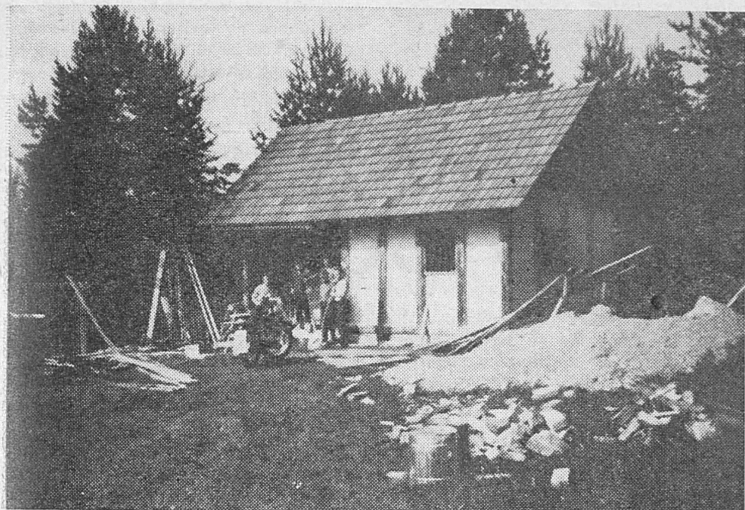
Lovska koč v izgradnji
