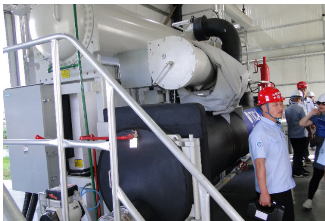
Sl. 4. Notranjost geotermalne elektrarne z močjo 280 kW z ORC tipom turbine v Tianzhenu (SV od Datonga), Shanxi demonstration base.
